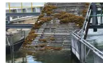
Construcción e instalación de un sistema mecánico para evitar la entrada de sargazo al condensador de la planta Barahona
