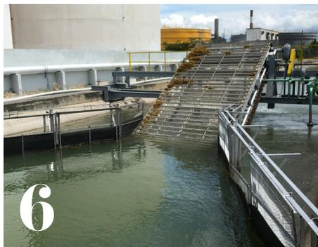
**6** Fue diseñado, construido e instalado por el personal de planta Barahona el SargazOut, un sistema mecánico que evita la entrada del sargazo al condensador, que ha permitido a la central mantener una operación continua.
